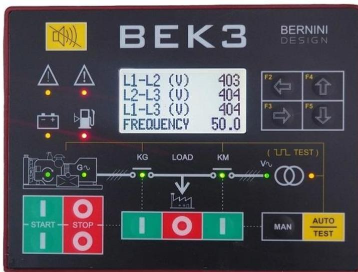
El controlador AMF suele ubicarse en la puerta frontal del panel de control AMF. Una interfaz intuitiva, compuesta por botones e indicadores LED, ofrece información instantánea sobre el estado de todo el sistema de reserva.
