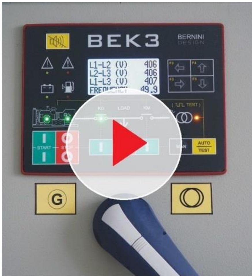
El controlador AMF compara los parámetros eléctricos de la red eléctrica (es decir, la red eléctrica) con un conjunto de ajustes internos. Cuando uno o más parámetros están fuera de rango, el relé activa el indicador de fallo de red. Esto puede utilizarse para realizar diversas funciones, como desconectar la carga y arrancar el motor. El controlador AMF está diseñado para aplicaciones de emergencia de propósito general.
